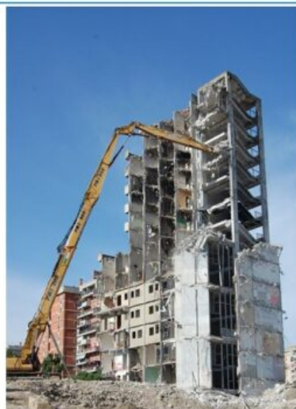
Abbattimento Vela A La «Superdemolition PMI 980» al lavoro
